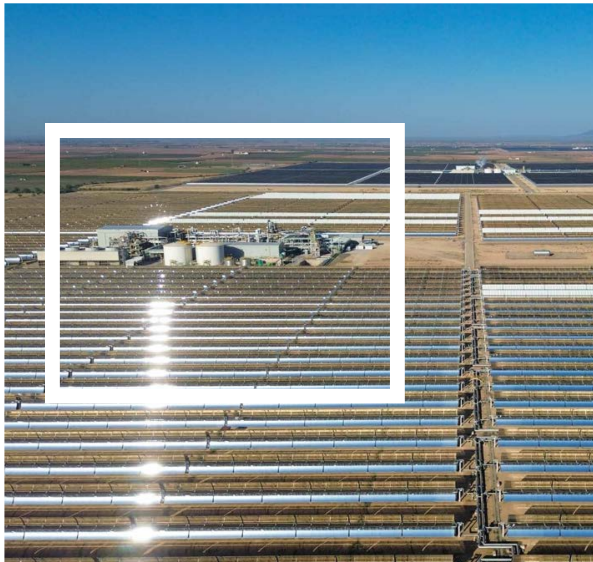
Central solar termoeléctrica Aste 1A en Ciudad Real (España)
