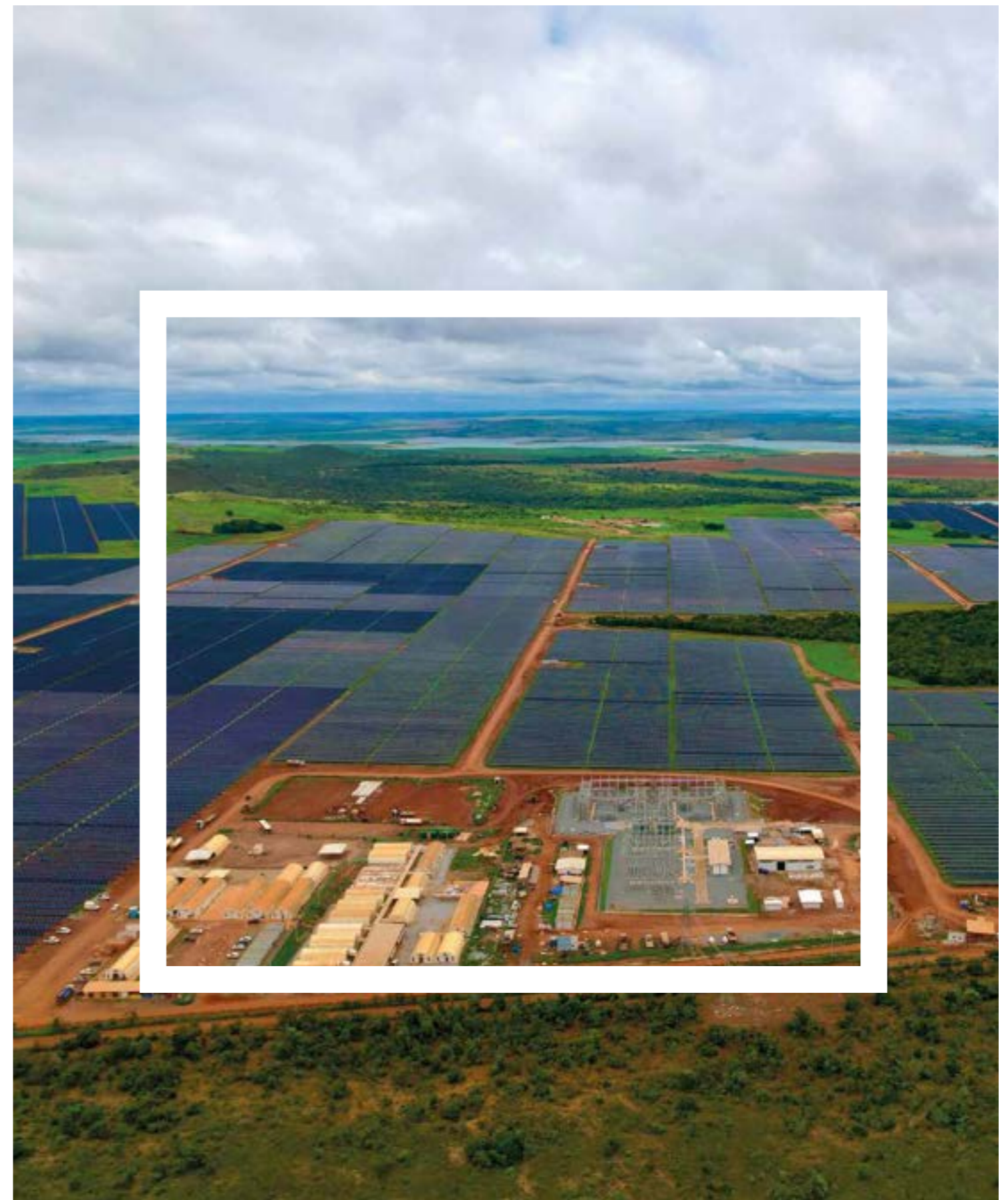
Parque solar fotovoltaico Boa Sorte (Brasil)
