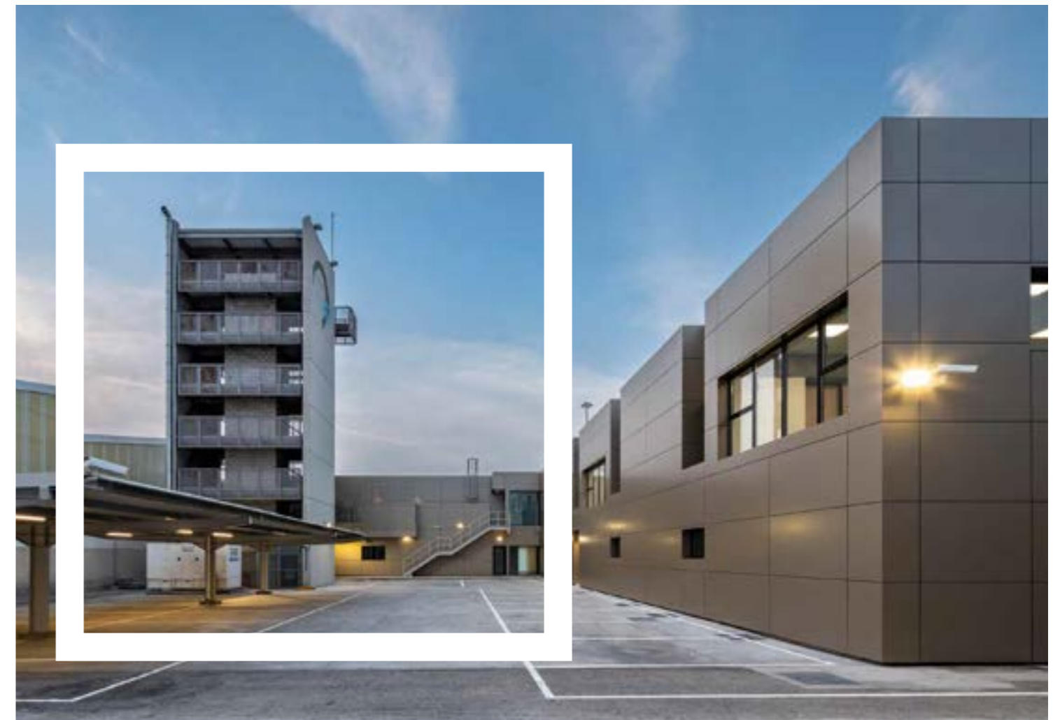
Centro de Coordinación de Procesos y Protección Portuaria en Algeciras, Cádiz (España)
