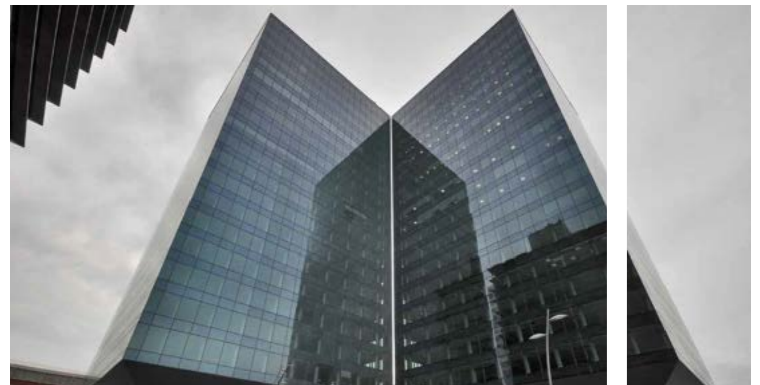
Construcción, instalaciones, cubierta e urbanización. Torre Iberdrola, Barcelona (España)
