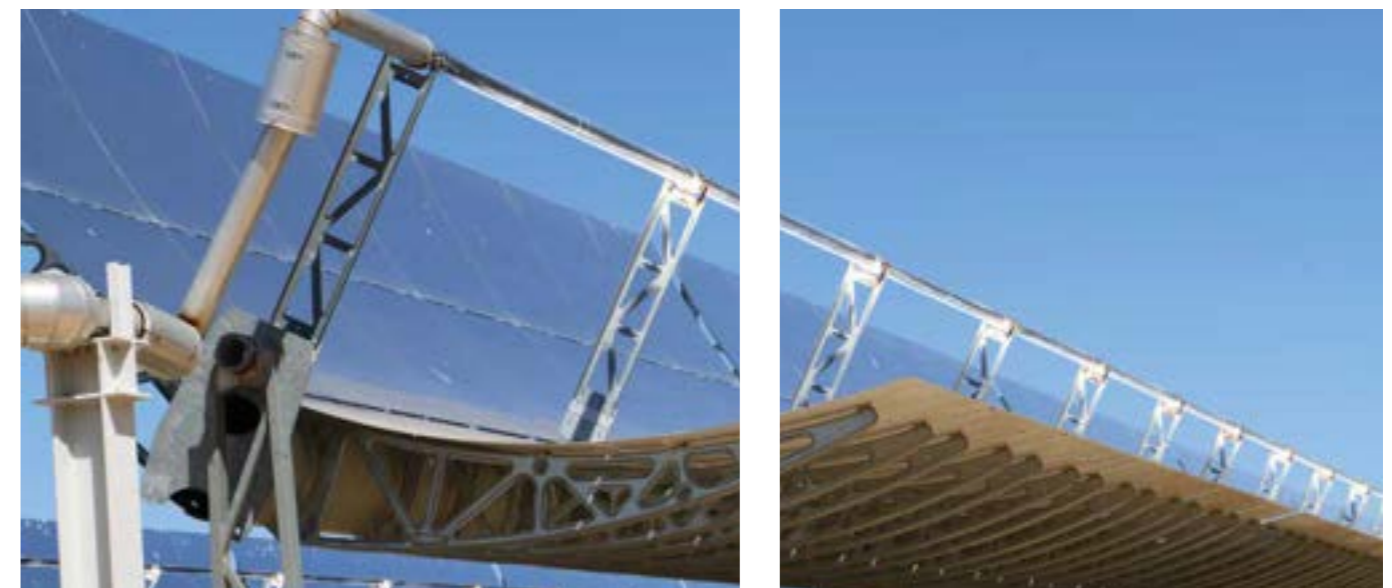
Central solar termoeléctrica Aste 1A en Ciudad Real (España)
