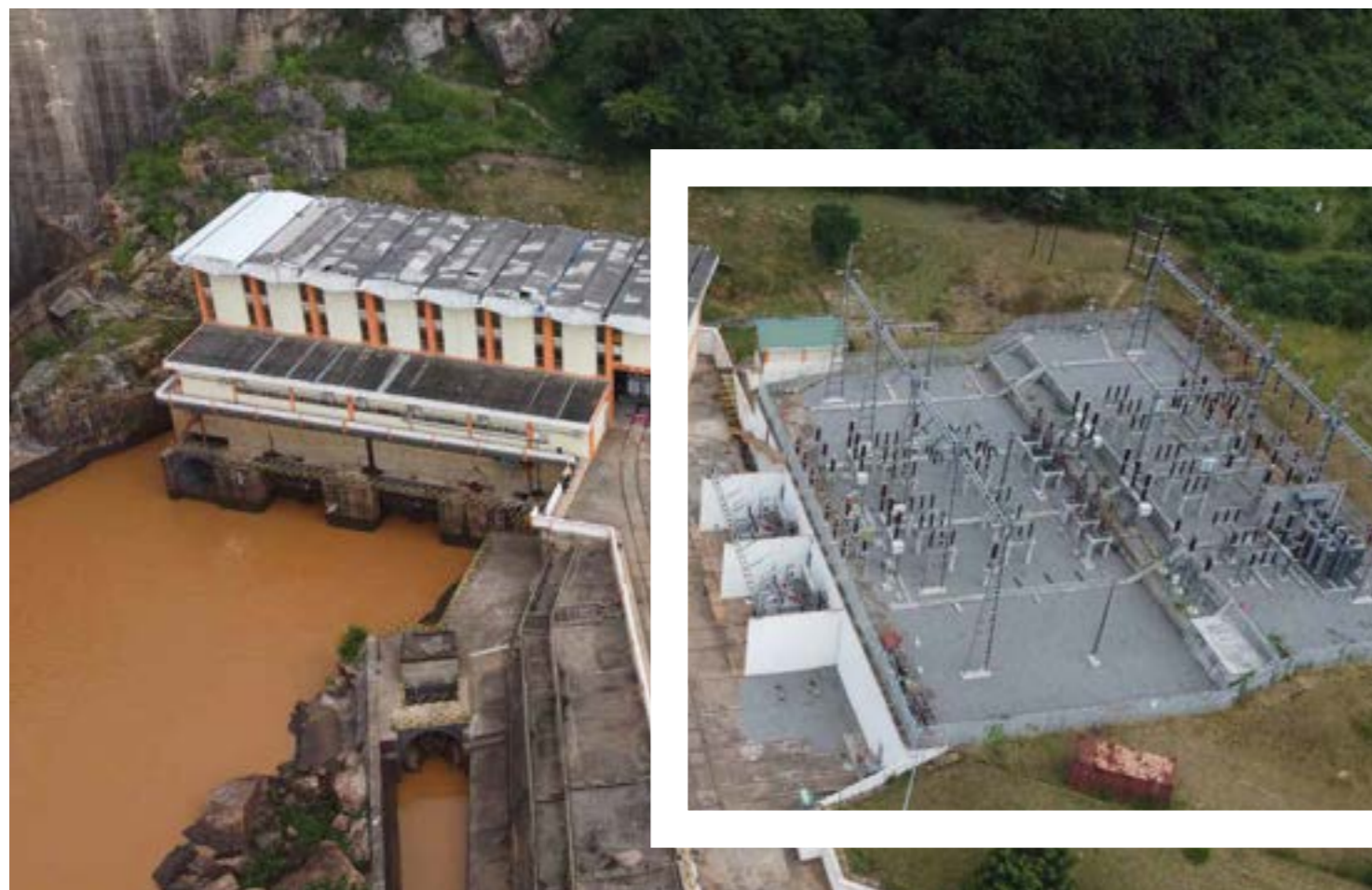
Central hidroeléctrica Chicamba (Mozambique)
