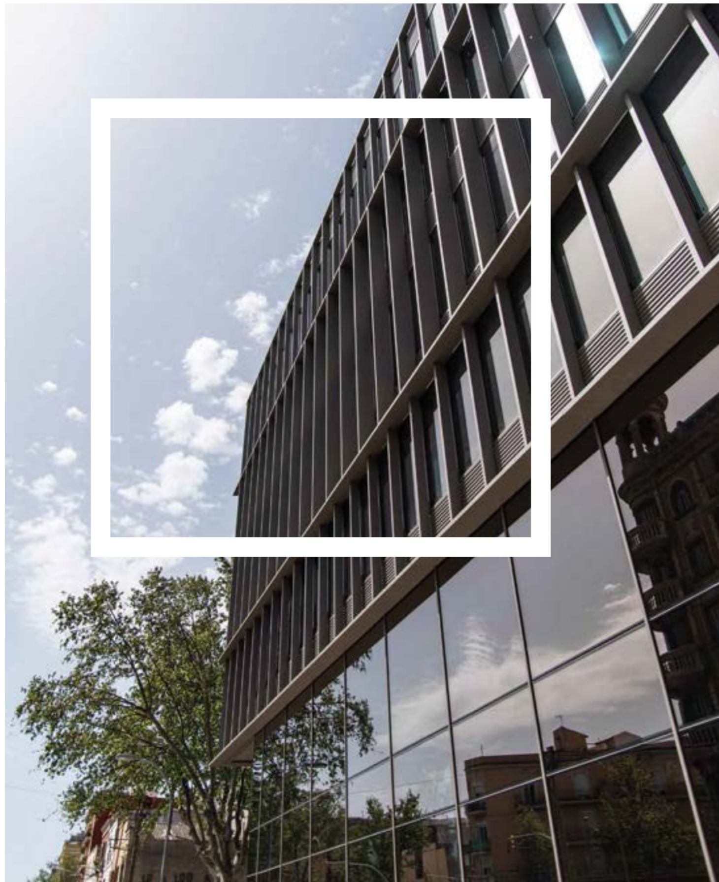
Construcción e instalaciones en edificio Diagrame en Barcelona (España)
