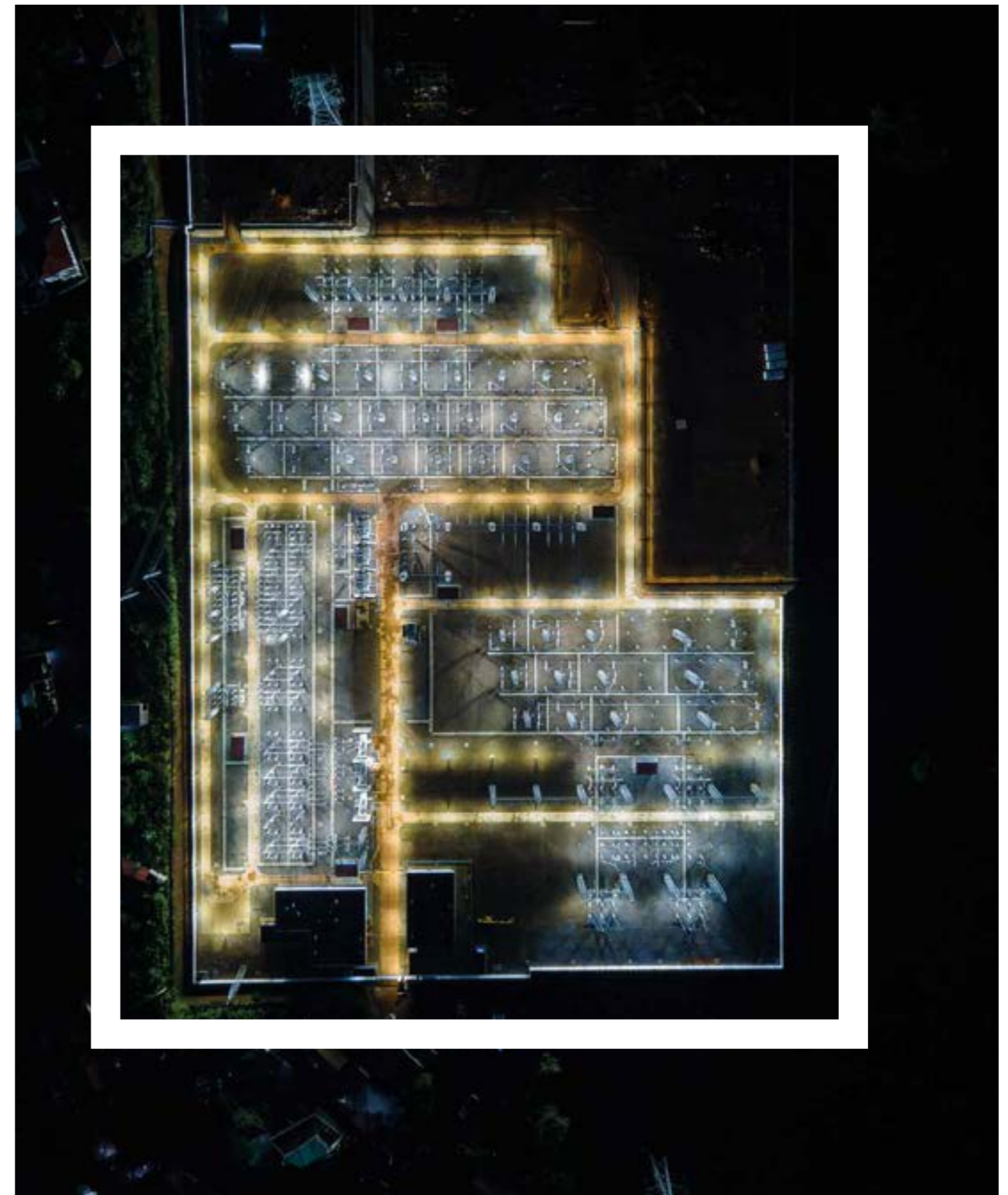
Subestación Nyom, Yaoundé (Camerún)
