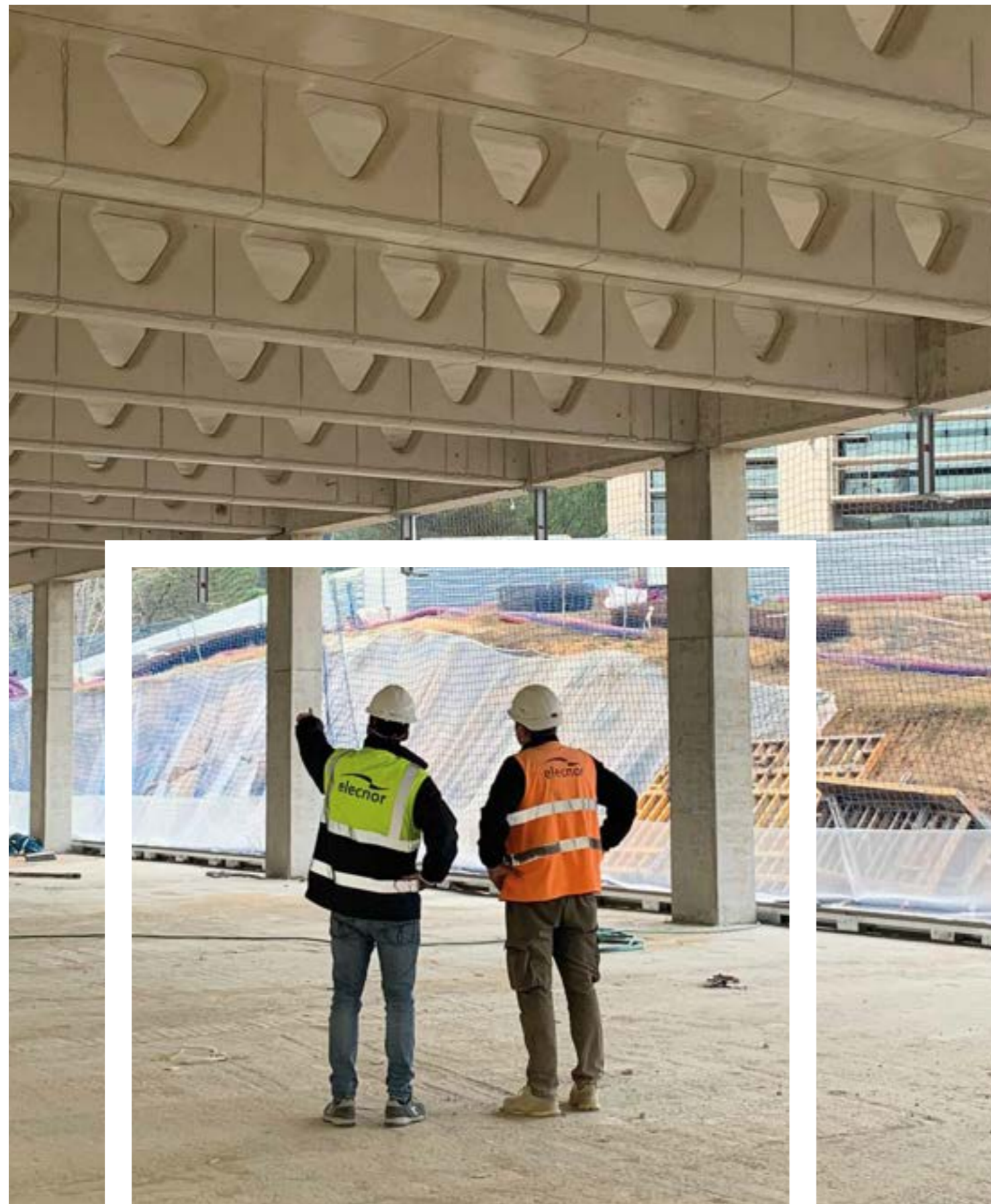
Construcción e instalaciones de oficinas para Nosce Roche, Barcelona (España)
