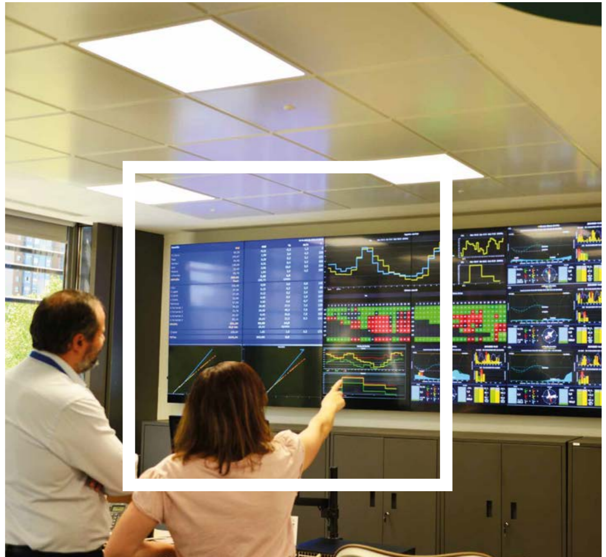
Control de parques eólicos. Enerfin
