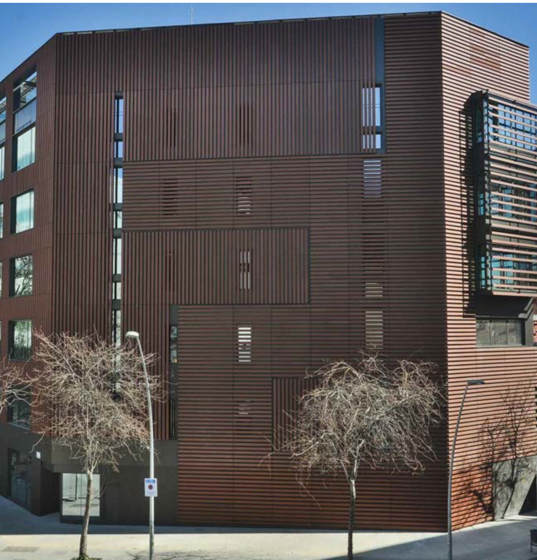
Construcción e instalaciones en edificio de oficinas Step-Up en Barcelona (España)
