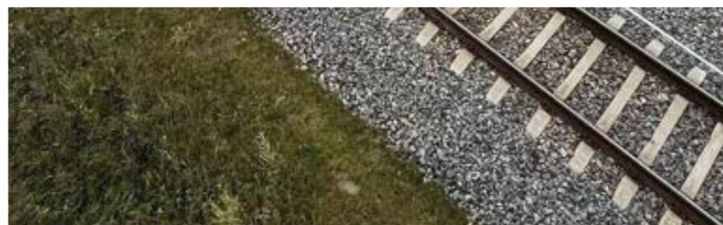
Electrificación ferroviaria Vilnius-Kapleida (Lituania)
