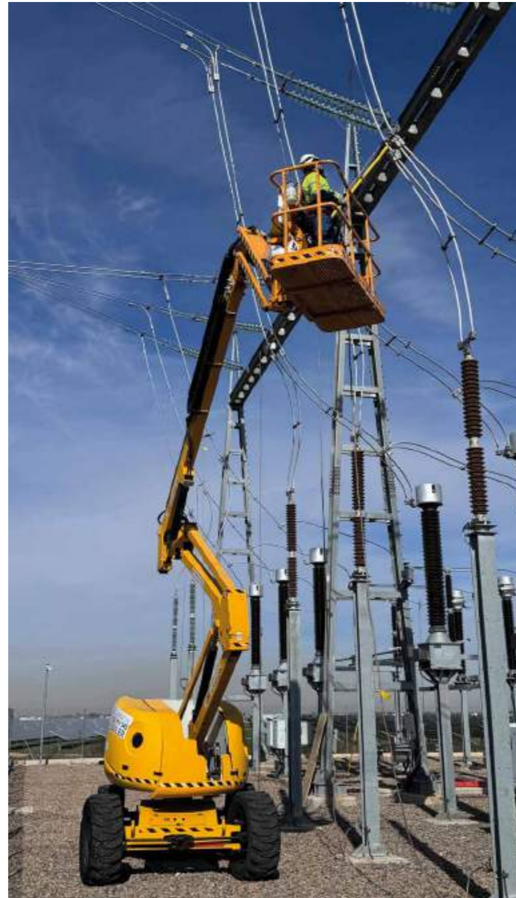
Cambio de aislador en línea de evacuación de la SET Nudo Manzanares (España)
