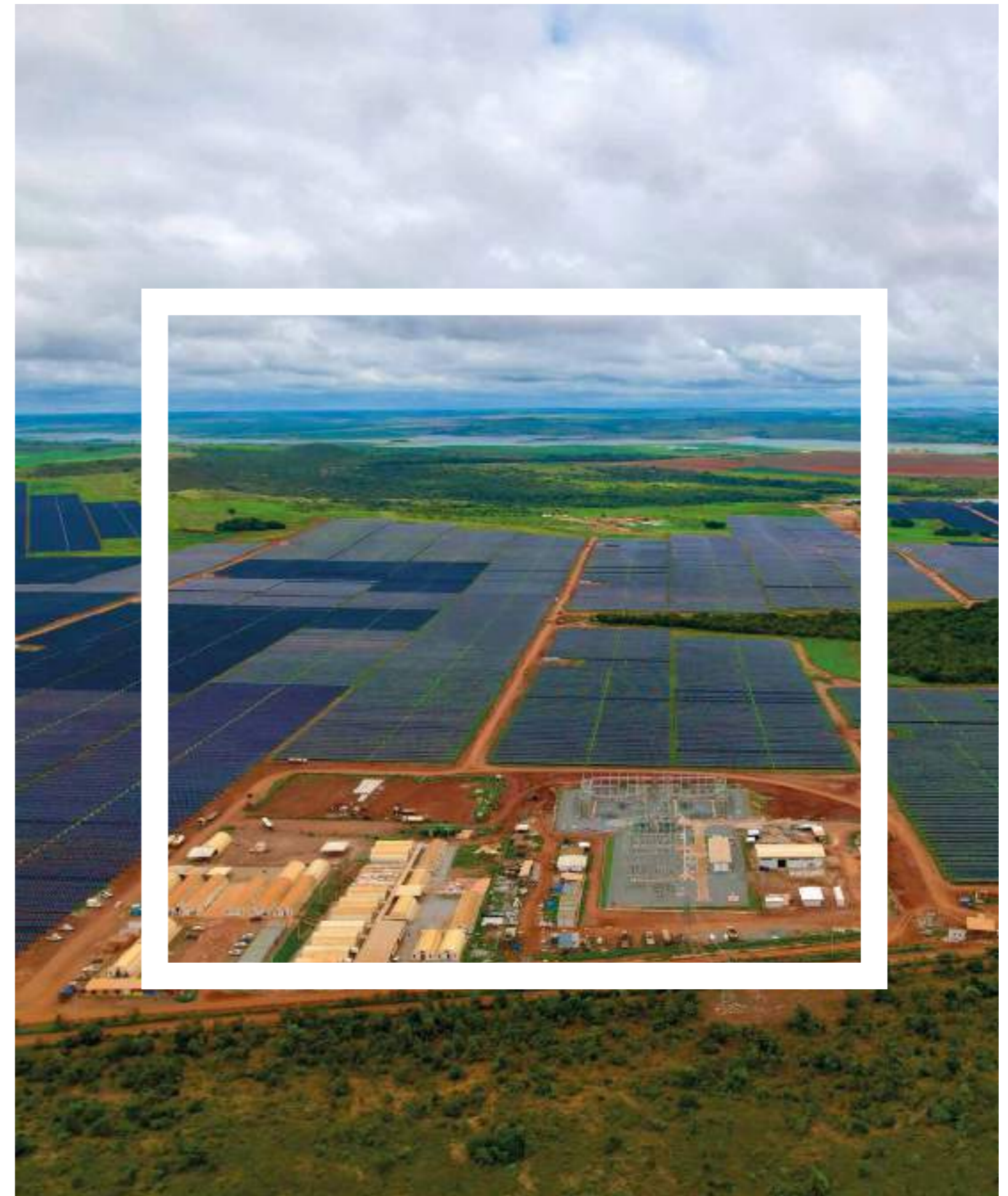
Parque solar fotovoltaico Boa Sorte (Brasil)
