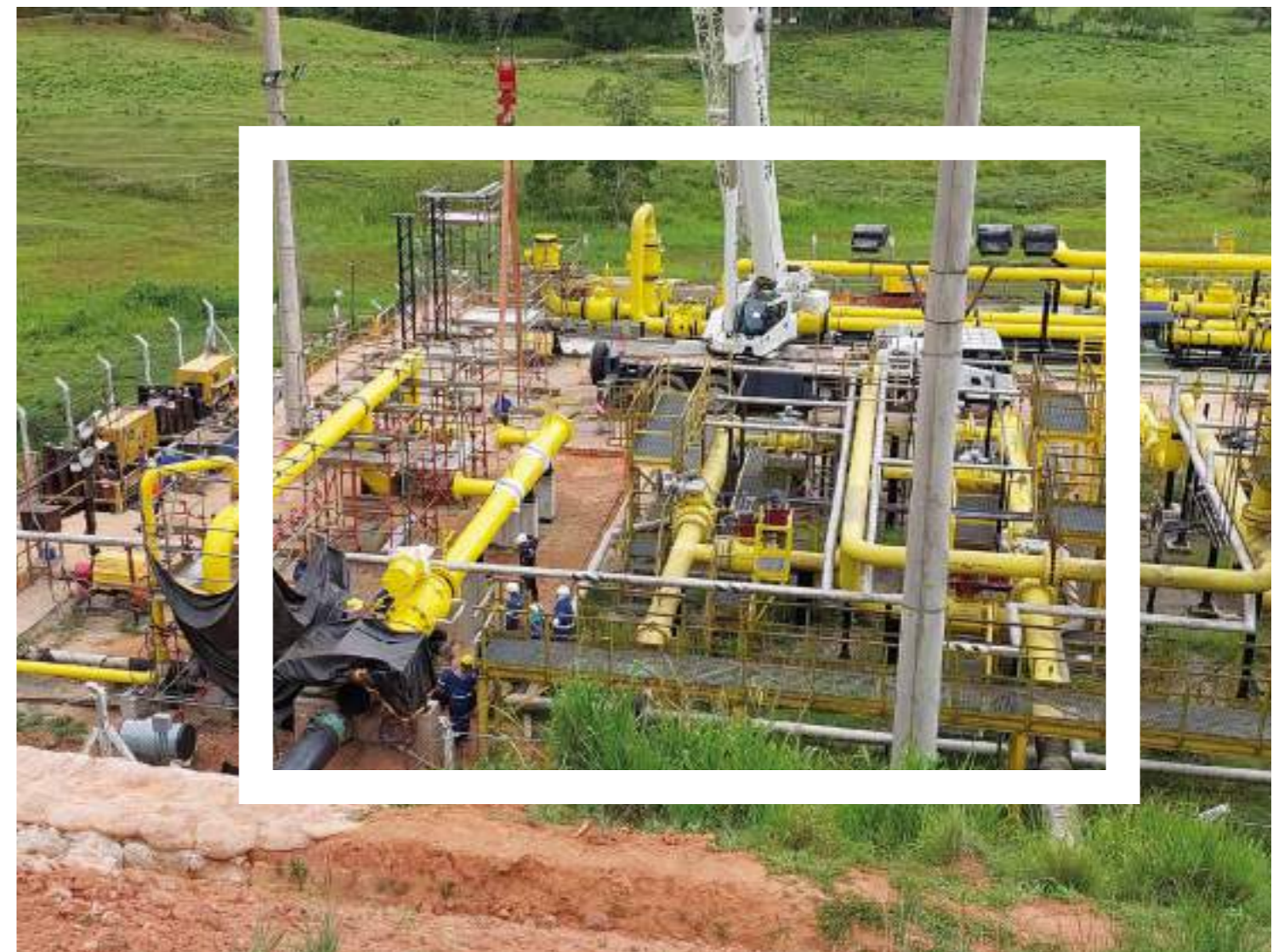
Gasoducto Gasig (Brasil)
