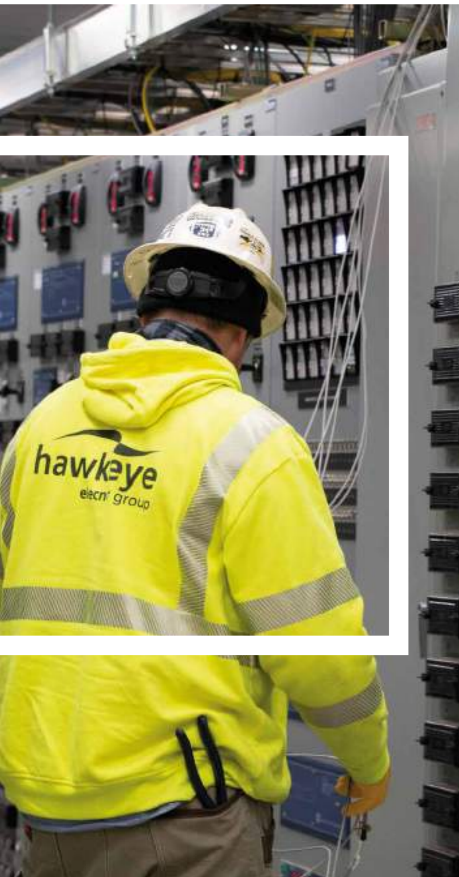
Ampliación de Subestación en Riverhead, New York (Estados Unidos). Eelec Nor Hawkeye
