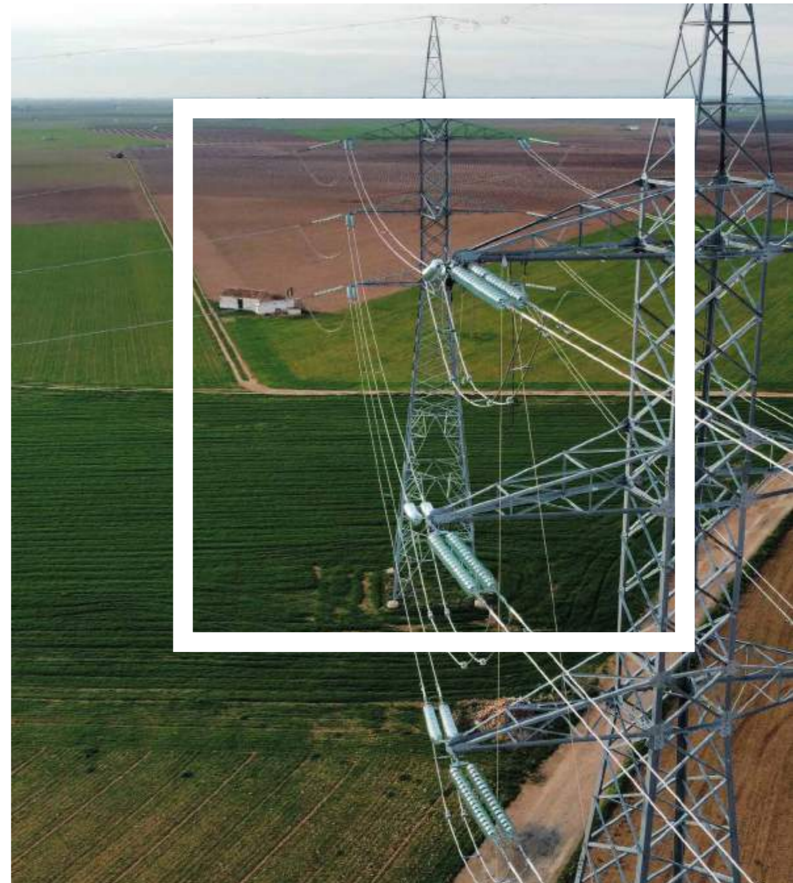
Cambio de aislador en línea de evacuación de la SET Nudo Manzanares (España)
