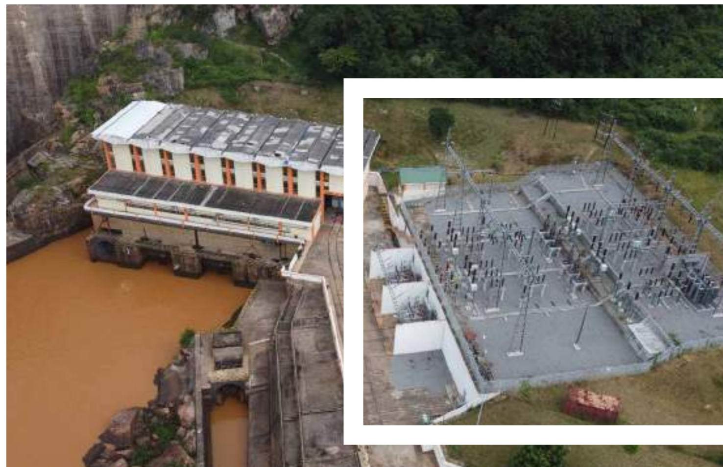
Central hidroeléctrica Chicamba (Mozambique)
