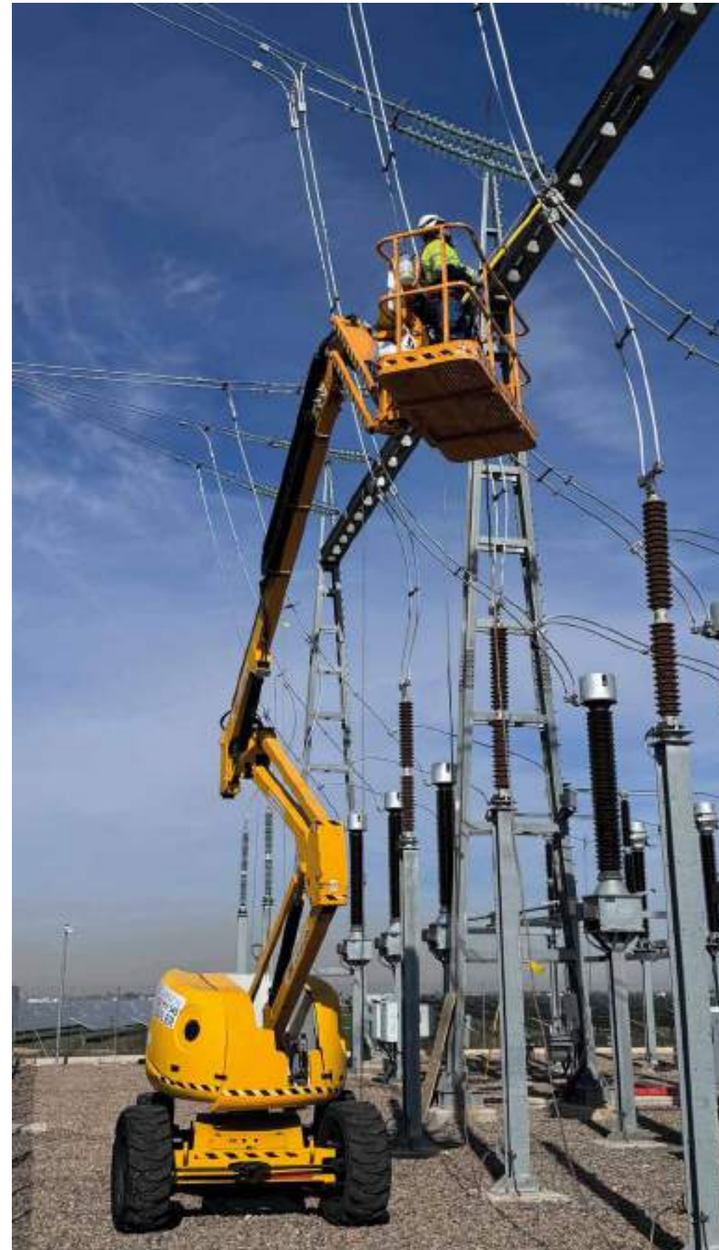
Cambio de aislador en línea de evacuación de la SET Nudo Manzanares (España)
