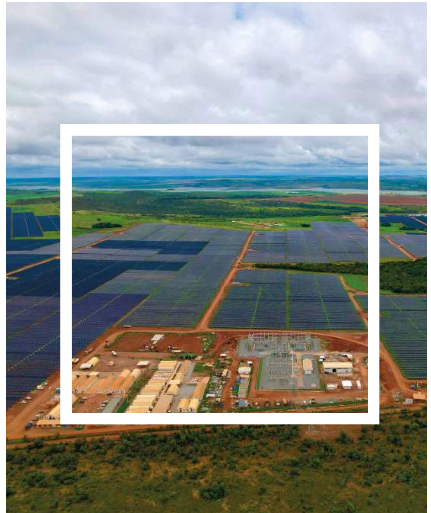
Parque solar fotovoltaico Boa Sorte (Brasil)
