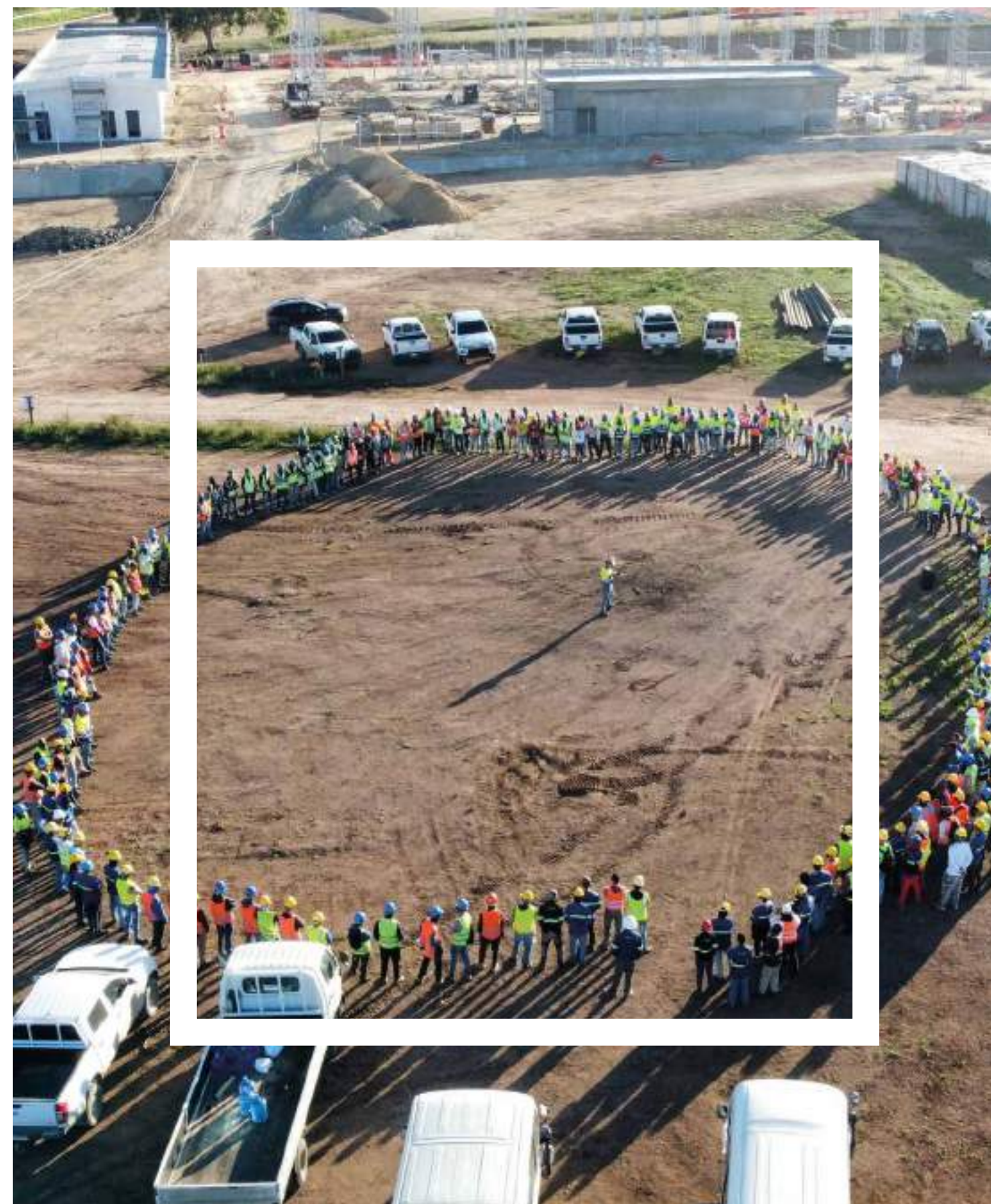
Parque solar fotovoltaico Sajoma (Rep. Dominicana)
