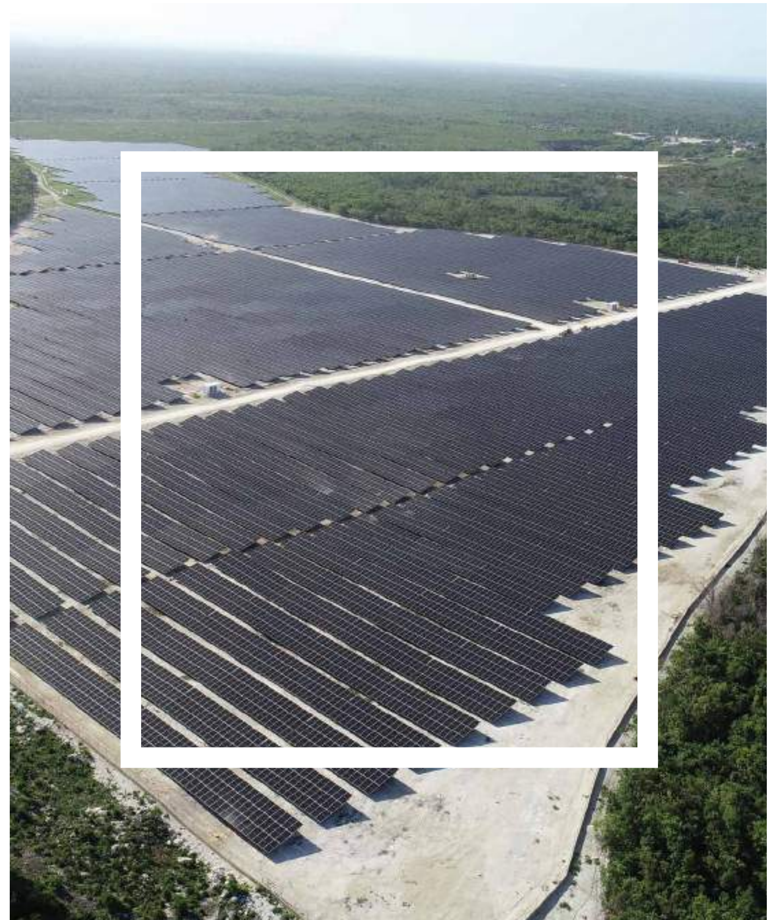
Parque solar fotovoltaico Bávaro (Rep. Dominicana)
