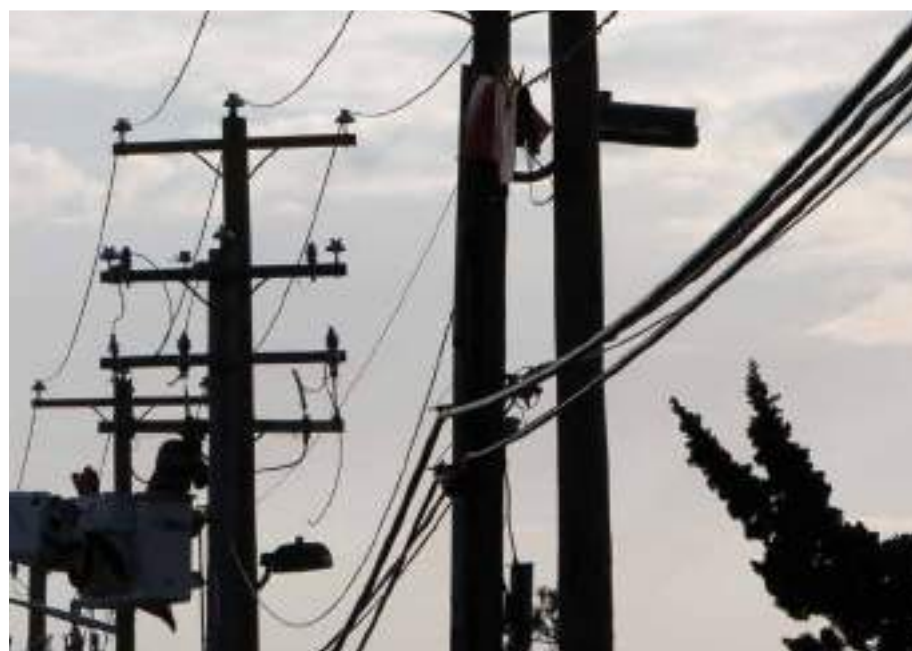
Restablecimiento de electricidad Long Island, Nueva York (Estados Unidos). Elec nor Hawkeye
