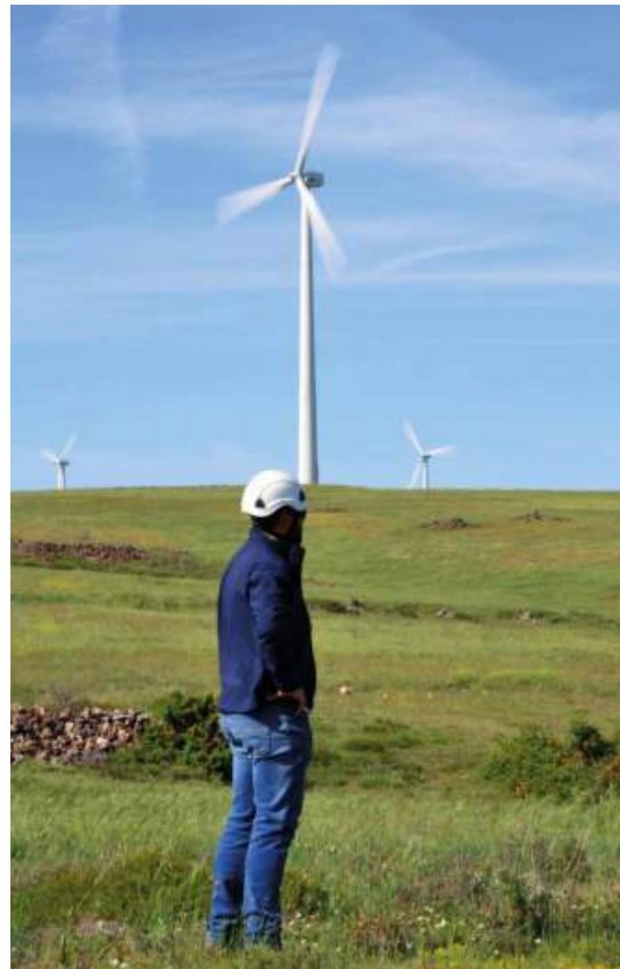
Parques eólicos de Páramo de Poza, Burgos (España). Enerfín
