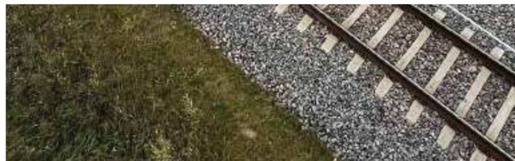
Electrificación ferroviaria Vilnius-Kapleida (Lituania)
