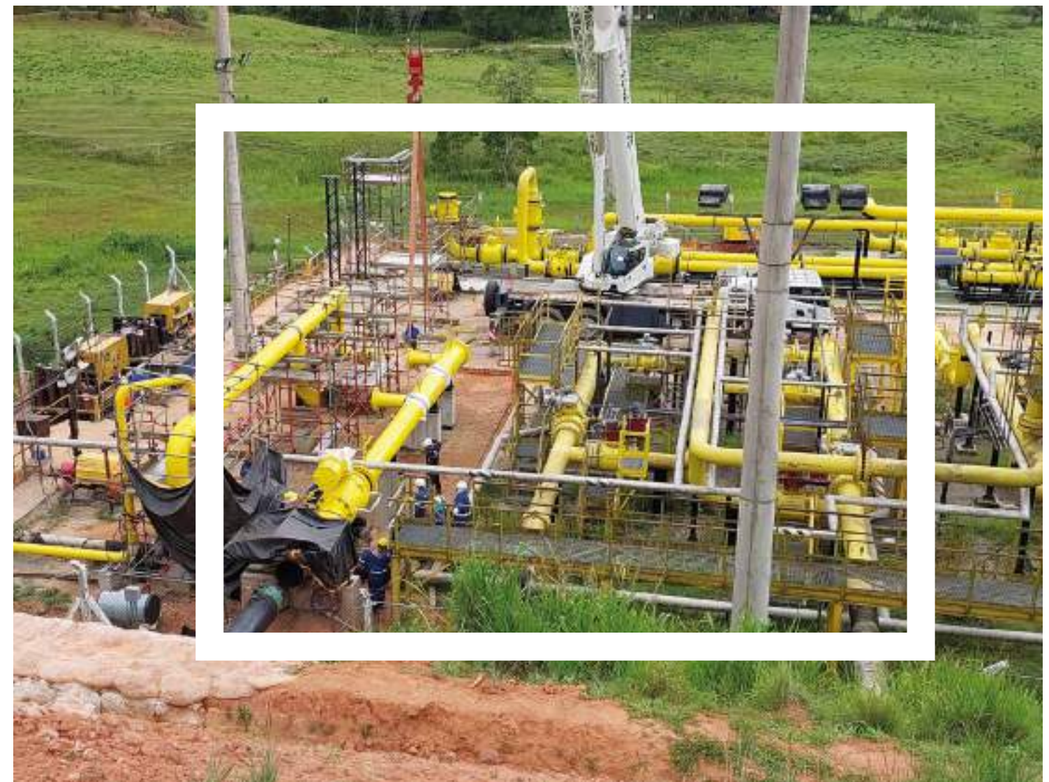
Gasoducto Gasig (Brasil)
