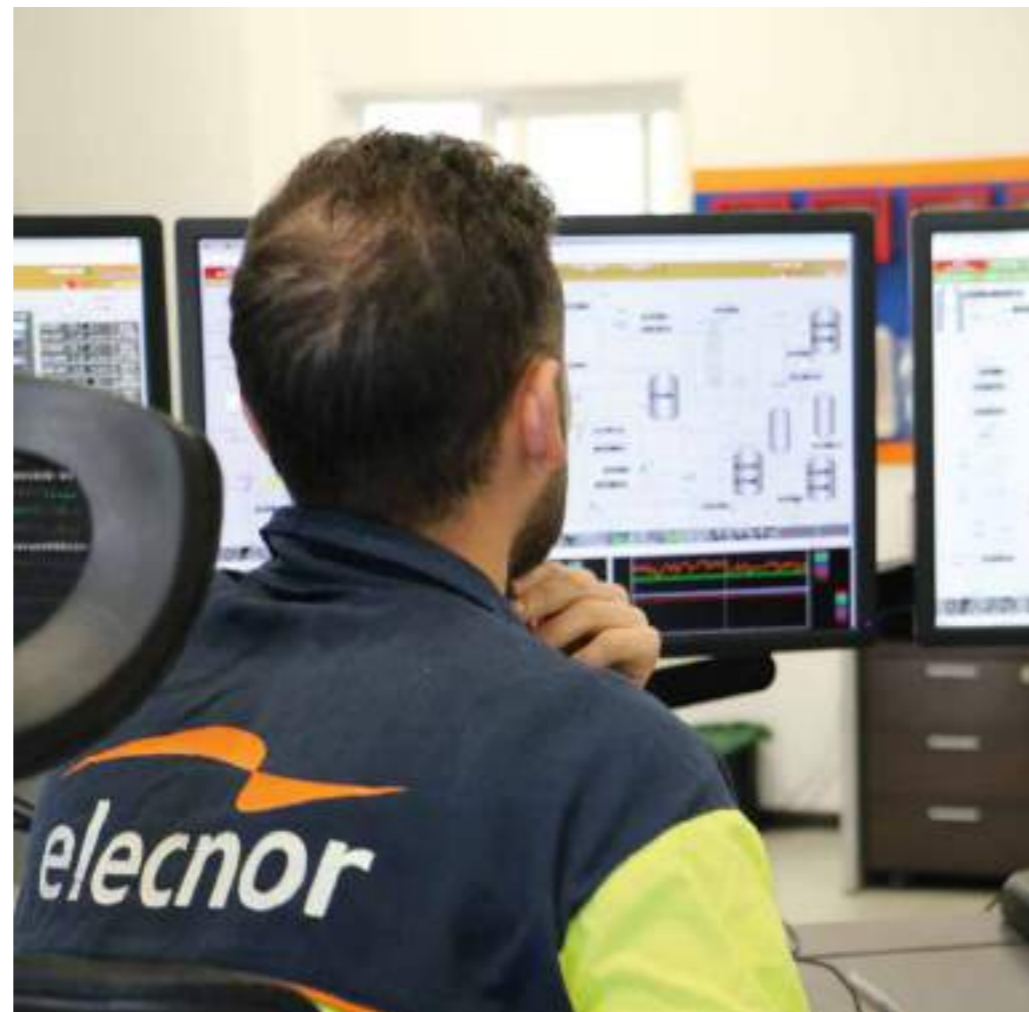
Aste 1A solar thermal power plant in Ciudad Real (Spain)
