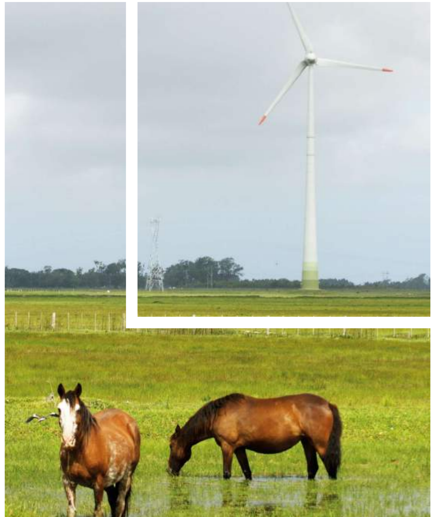
Osório wind farm complex (Brazil). Enerfín
